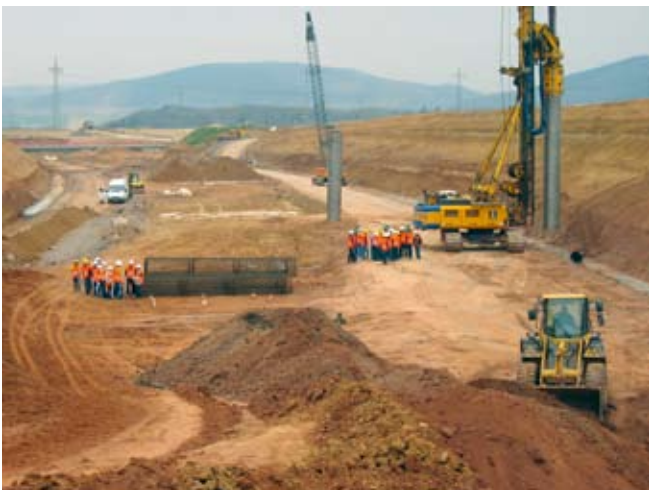
Trierer Schüler auf der Großbaustelle
